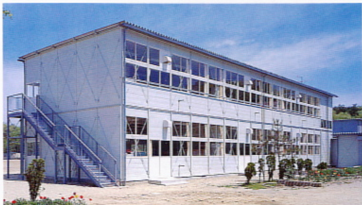
タウン21 / 学校仮設校舎
